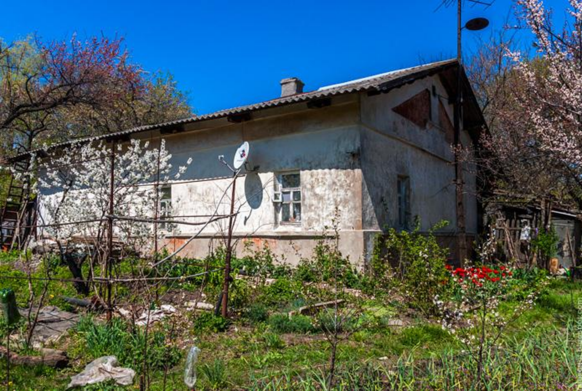
Подсобное здание вокзала постройки 1878 года
